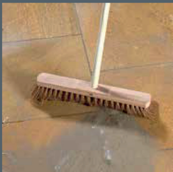
Entfernung letzter Mörtelreste mit Kokosbesen
