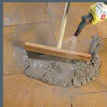
Einarbeiten mit Hartgummischieber und Wassersprühstrahl
